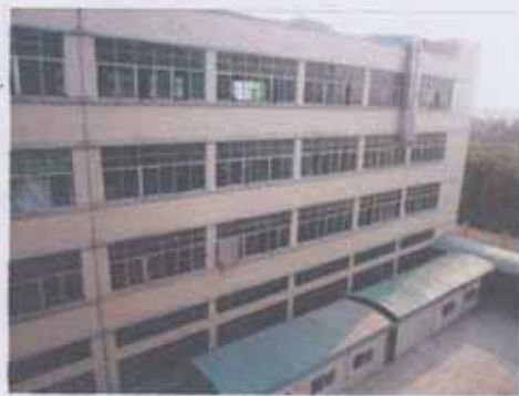
南面-工业区厂房
