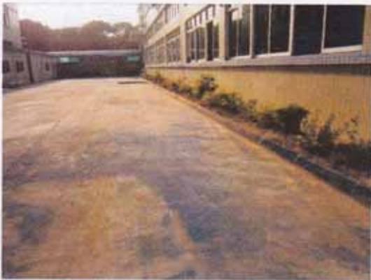
项目废水处理设施预留地
