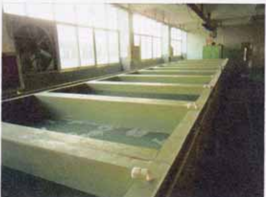
项目表面处理池
